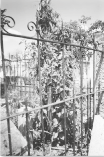
Gráfica 1: Detalle de la herrería artística de forjado que delimita el apartamento judío más antiguo (posiblemente de la década de 1930). Se trata de un enrejado de sencillo diseño compuesto de barras de hierro con puntas entorchadas y sujetas por pletinas perforadas y de volutas simples fijadas mediante abrazaderas.
